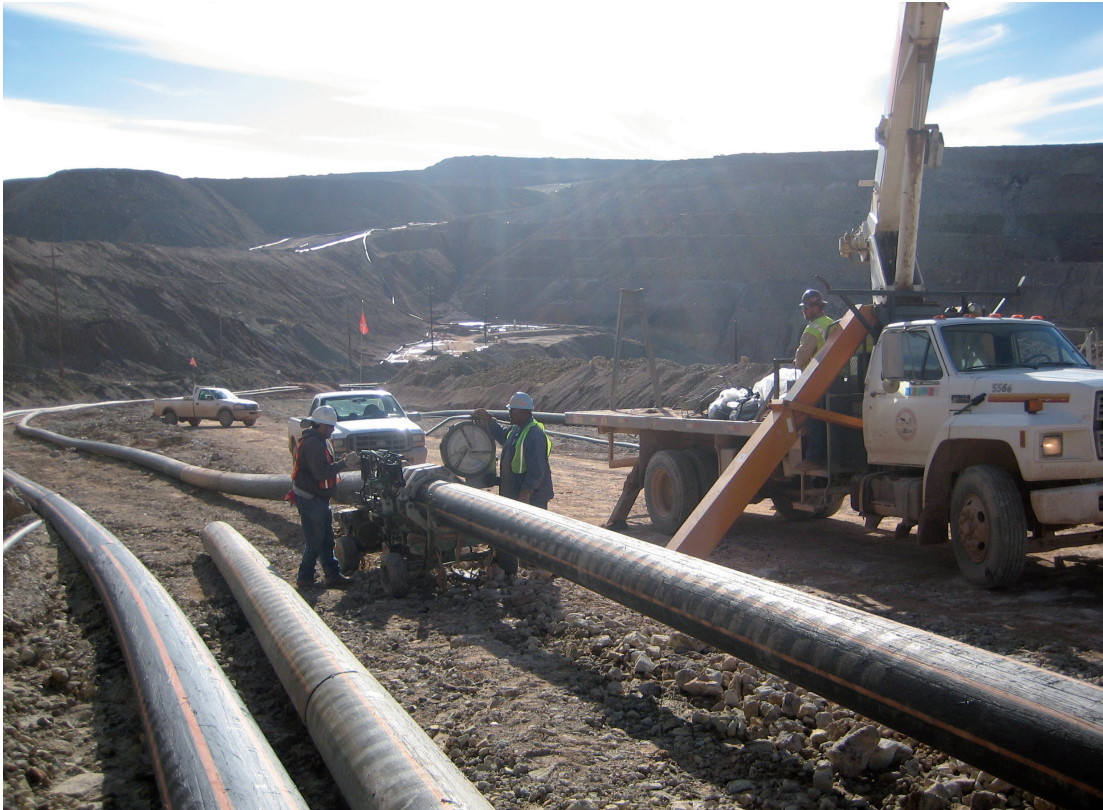
Figura 3.6 Operaciones de Construcción de la Conducción de Suministro de Agua a una Mina
