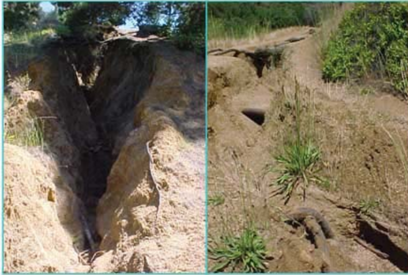
FOTO N° 9: SE APRECIA EN LA IMAGEN COMO AL DESPROTEGER LAS LADERAS DE SU VEGETACION NATURAL A TRAVES DE LA CORTA DE ARBOLES, QUEMA, Y INADECUADO COMPORTAMIENTO DE LOS TURISTAS Y COMUNIDAD LOCAL, SE PROVOCA LA EROSION DEL SUELO,
