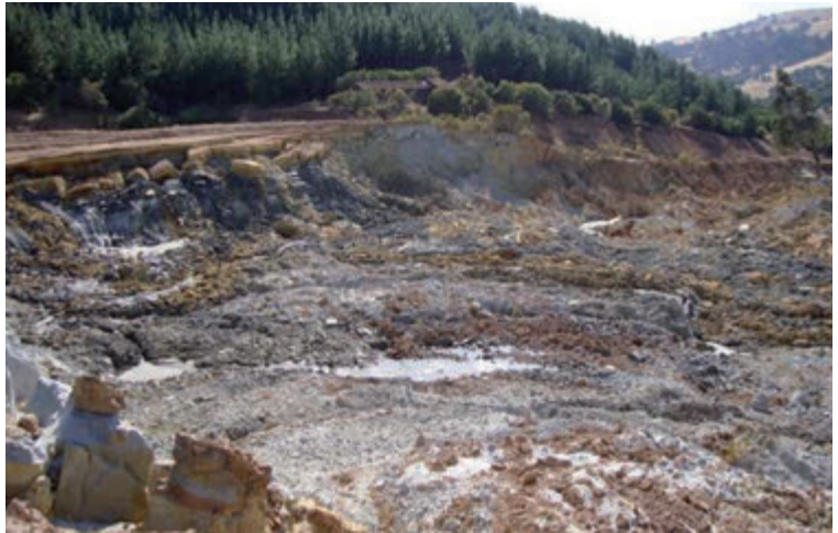
Tranque de relave Las Palmas captado después del colapso. Crédito: Sernageomin
