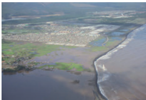
Tres aspectos de la ciudad de Concepción tras el tsunami vistos desde el aire: el puente Juan Pablo II (arriba), el estadio y terminal de buses de Collao (abajo, izquierda), y la zona adyacente a la boca sur del río San Pedro (abajo, derecha).
