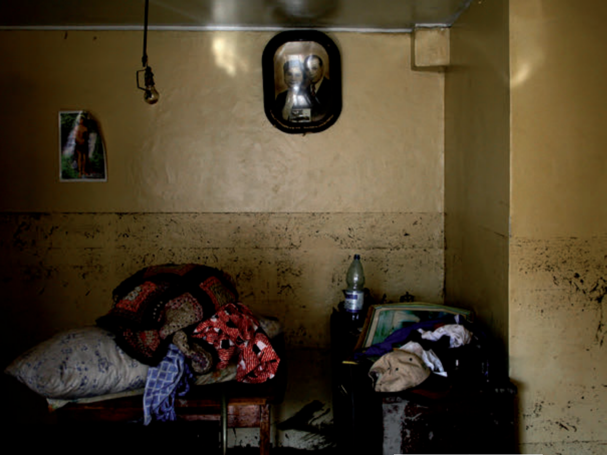
Huellas del tsunami en el interior de una casa en Talcahuano. Crédito: Nicolás Sáez CF/C
