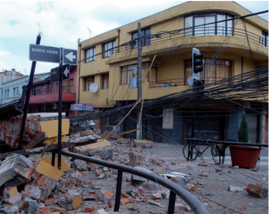
Un aspecto de los daños provocados por el 27F en la ciudad de Concepción, Crédito: Manuel Morales C/CF
