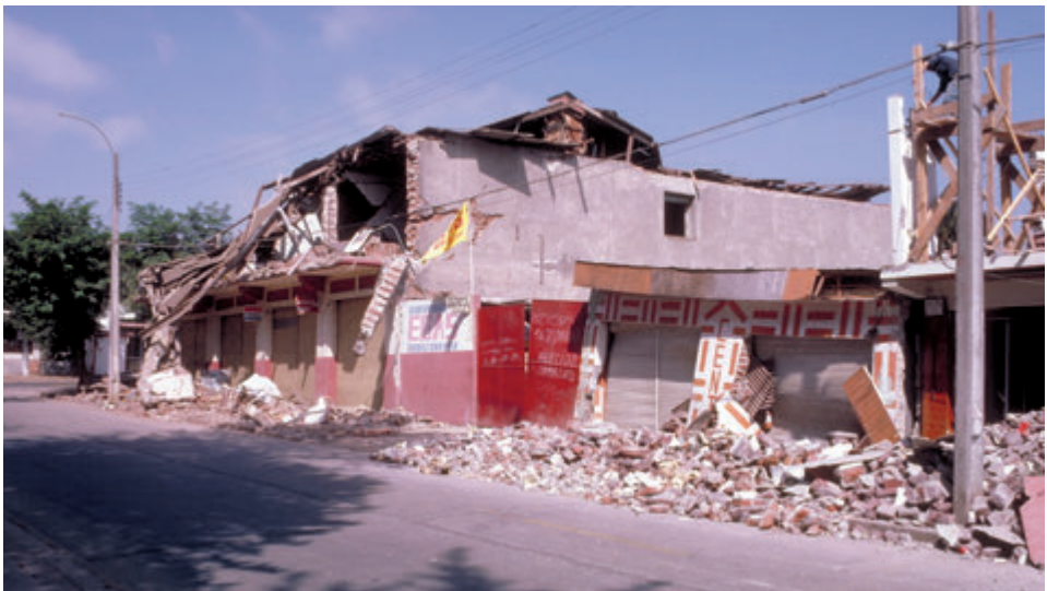
El terremoto de 1985 en la zona central del país, pese a ser de menos de 8 grados Richter, provocó importantes daños en las edificaciones, especialmente aquellas de adobe.
