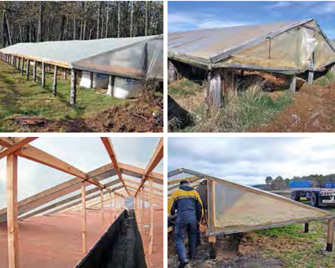
Figura 26. El tendadero es una especie de invernadero colgante, estructuralmente es de madera, techo de polietileno y presenta una malla en su interior, para soportar el musgo durante el secado y cubrirlo para evitar pérdidas por viento. Las dimensiones son de 40 metros de largo, 5 metros de ancho y 2,5 metros de alto. Este tipo de secadero tiene la capacidad de secar 80 sacos húmedos, durante 3 a 5 días.
