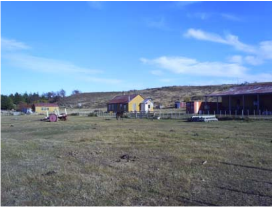
FIGURA 19. Instalaciones de la estancia
