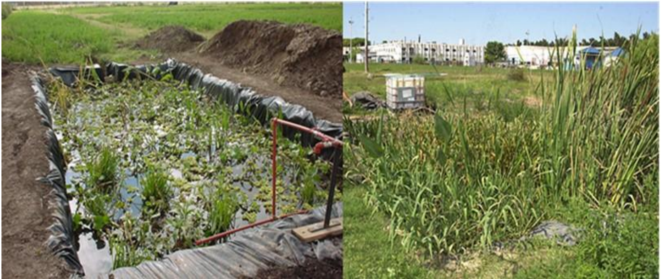
Figura. 1. Humedal a escala piloto a 1 mes (a) y 6 meses (b) del inicio de su funcionamiento.
