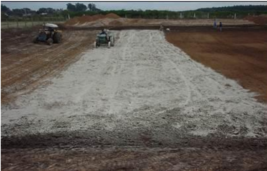
Figura. 3. Impermeabilización del área del humedal con bentonita.
