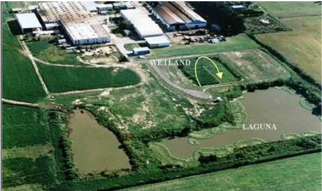
Figura. 2. Vista aérea del humedal de tratamiento y la laguna donde desagua.
