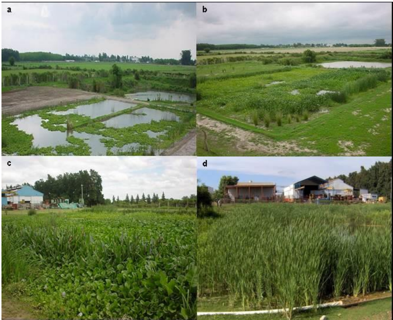
Figura. 4. Etapa de desarrollo de la vegetación en el humedal de tratamiento: a) luego de 15 días del trasplante, donde se observa el tabique central; b) a los 4 meses; c) al año de operación; d) después de 2 años, donde se observa la dominancia de especies emergentes y el caño de ingreso del efluente.
