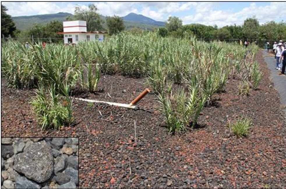
Figura 3. Humedal subsuperficial de flujo horizontal para el tratamiento de efluentes provenientes de la comunidad rural de San Jerónimo Purenchécuaro en la cuenca del Lago de Pátzcuaro en el Estado de Michoacán (Méjico) que utiliza como sustrato al “tezontle”, donde se desarrolla las especies emergentes T. domingensis y A. donax . Este sustrato es una roca de origen volcánico abundante en la región (Fotos: Hernán Hadad).
