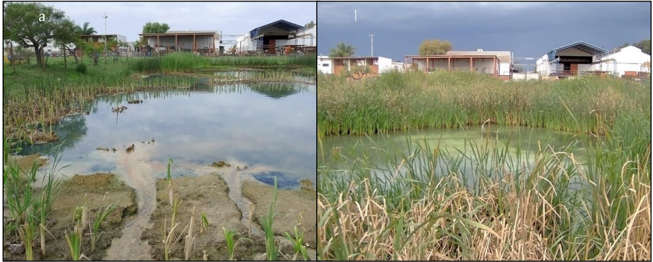
Figura 2. Humedal de flujo libre superficial para el tratamiento de efluentes de una industria metalúrgica en la ciudad de Santo Tomé, provincia de Santa Fe (Argentina), donde se observan taludes para favorecer el aumento de cobertura de T. domingensis recién plantados (a) y al cabo de 6 meses (b) (Fotos: Hernán Hadad).
