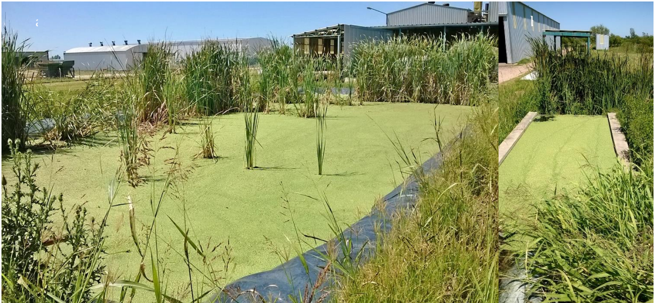
Figura 6.- Vista de un humedal construido en Santa Fe (Argentina) para el tratamiento de un efluente industrial (a) y la cámara de cemento en la zona de salida del mismo (b) donde se observa la dominancia de Lentejas de agua y la escasa presencia de Typha domingensis (Fotos: Hernán Hadad).
