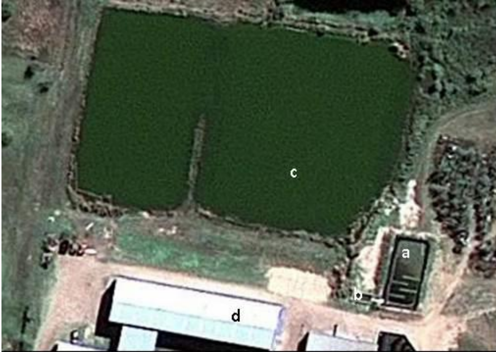
Figura. 7. Vista aérea del humedal de tratamiento (a), la pileta de salida (b), la laguna (c) y las instalaciones de la empresa (d).
