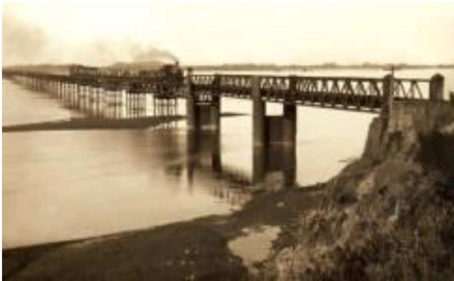
Figura 77: puente ferroviario a San Pedro de la Paz (1930) Fuente: web. archivo histórico de Concepción
