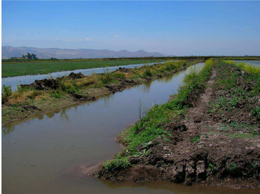
Foto 4: Pretil sector norte que transporta las aguas a la bomba Buda. Fuente: CONAMA RM
