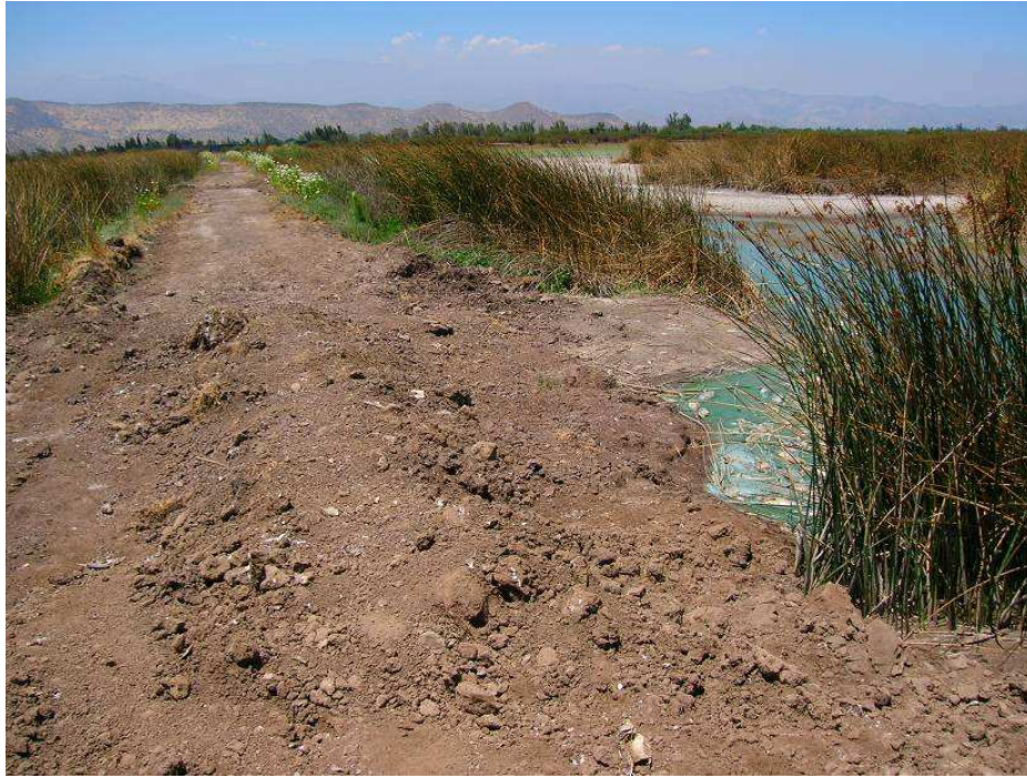
Foto 3: Bloqueos en pretil sur. Se diferencia el suelo compactado del que no lo está. Se pueden ver los peces muertos a la derecha.
