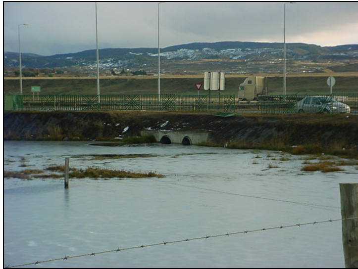
Fotografía 2.7: Alcantarilla situada al oriente del mirador
