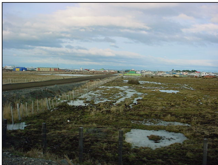
Fotografía 2.5: Terraplén de Av. Los Generales
