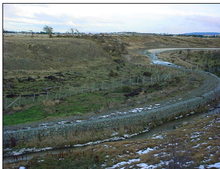
Fotografía 2.3: Obras terminales del canal de trasvase
