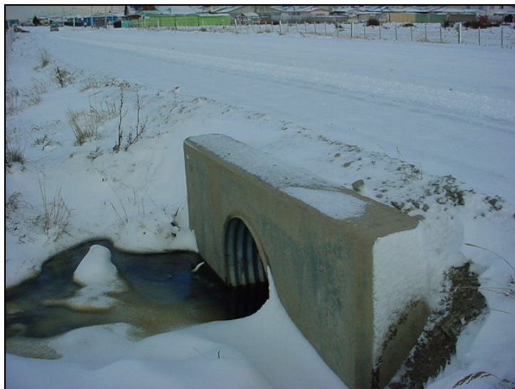
Fotografía 2.8: Alcantarilla en prolongación de la Av. Los Generales
