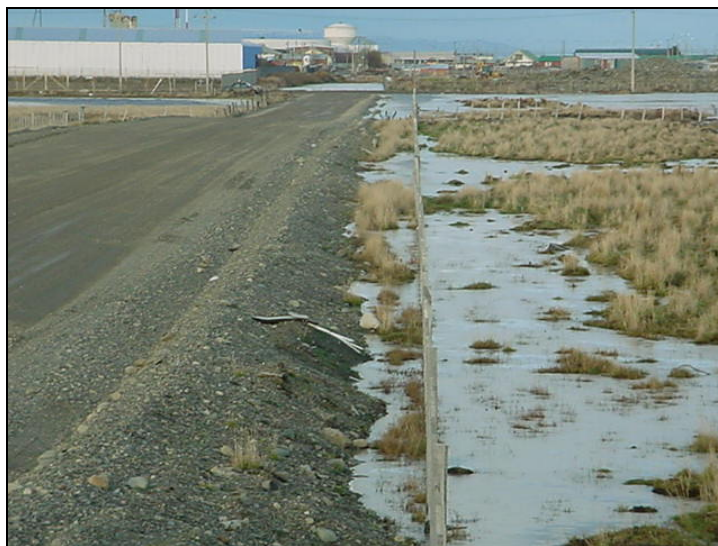
Fotografía 2.4: Terraplén de calle Retiro
