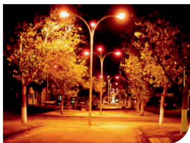
Cambio de luminarias en avenida Las Delicias, Vicuña.
