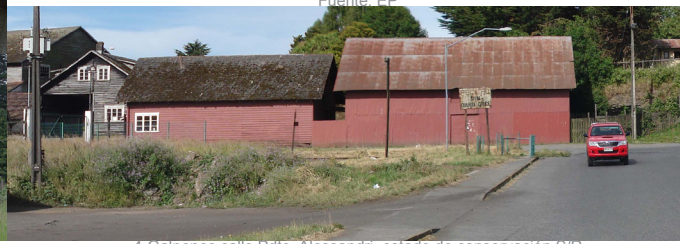
4-Galpones calle Pdte. Alessandri, estado de conservación S/R Fuente: EP
