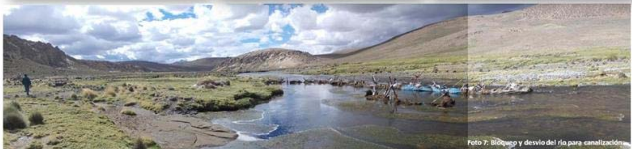
Foto 7: Bloqueo y desvío del río para canalización.
