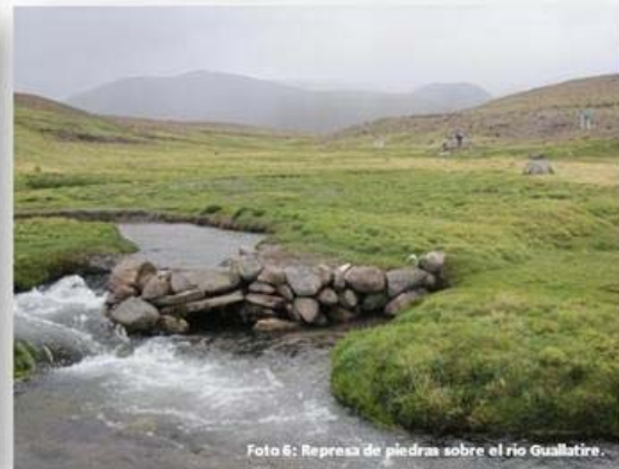
Foto 6: Represa de piedras sobre el río Guallatire.
