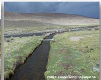
Foto 3: Canalización río Caqueña.
