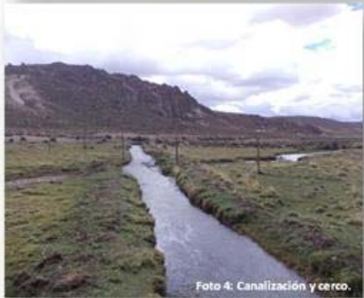
Foto 4: Canalización y cerco.
