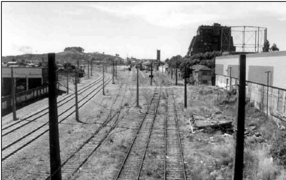
FIGURA Nº6: LA PERIFERIA O EL BORDE QUEDA SEGREGADO DEL CENTRO POR LA LÍNEA FÉRREA Y GRANDES CONSTRUCCIONES QUE ACTÚAN COMO BARRERAS URBANAS.
